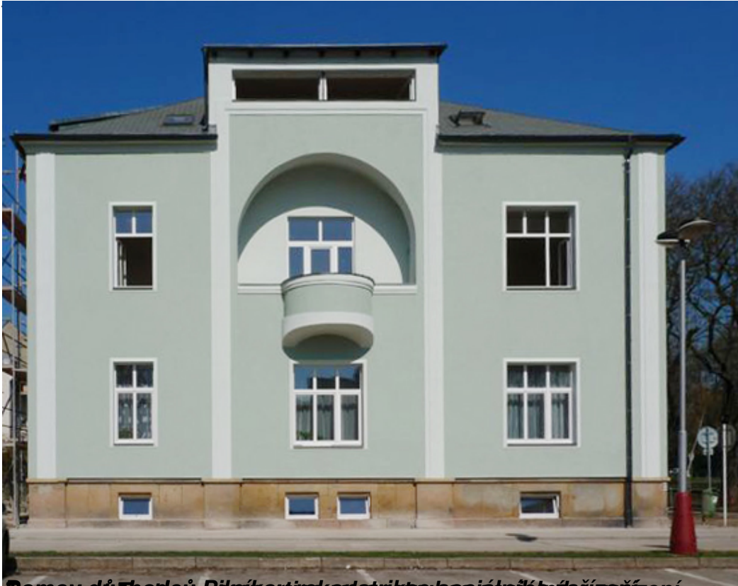
Demondáž teplovodní plynokotelné elektrické a plynové příslužnosti
